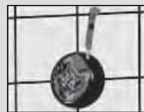
Überstehenden Bereich der UP-Box bündig abschneiden, Wasser absperren und Spülaufsatz demontieren.
